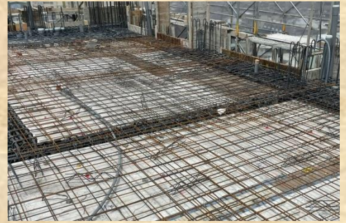
上層鋼網鋪設完成
