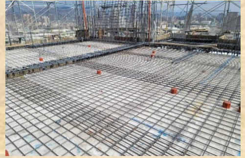
下層鋼網鋪設完成
