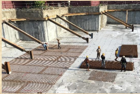
基礎下層網鋪設
