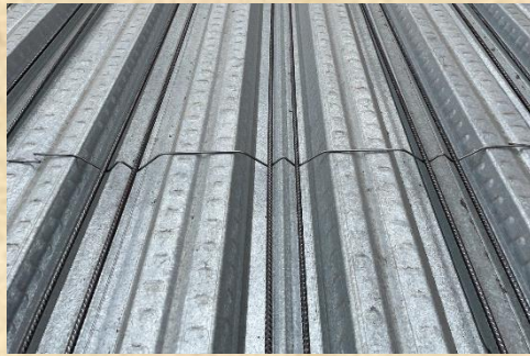
吊鉤及槽底筋
