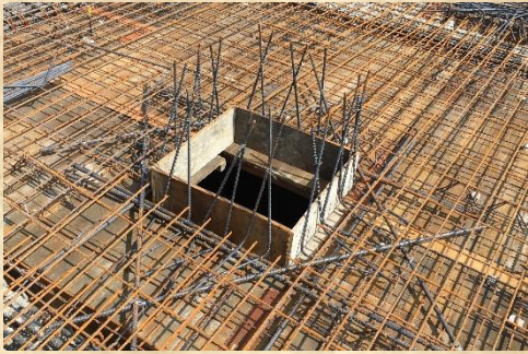
預留孔開孔補強
