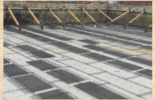
基礎上層鋼網寄料
