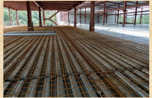
鋼網鋪設完成
