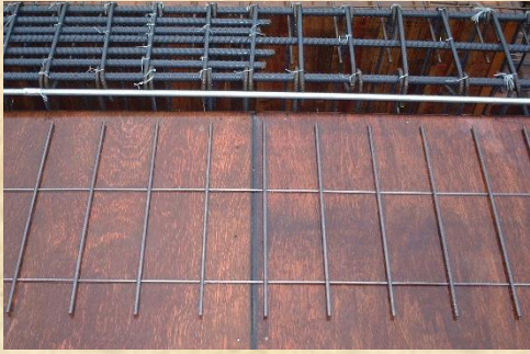
下層鋼網入樑錨錠
