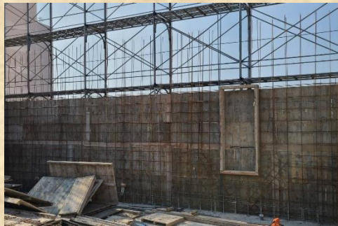
牆筋開口補強
