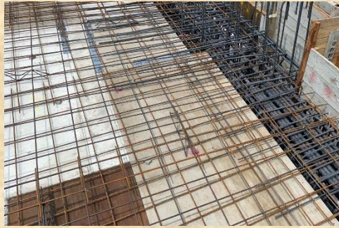
上層鋼網上樑鋪設
