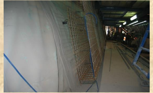
隧道二次襯砌
