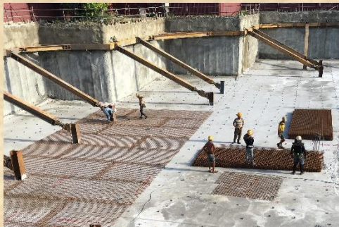
基礎下層網鋪設
