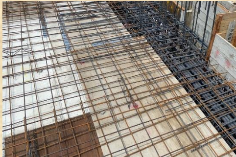
上層鋼網上樑鋪設
