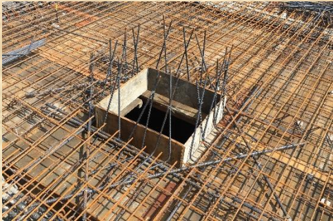
預留孔開孔補強
