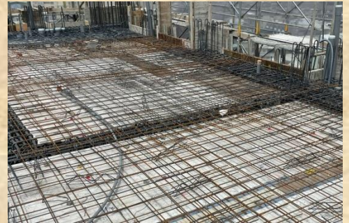
上層鋼網鋪設完成
