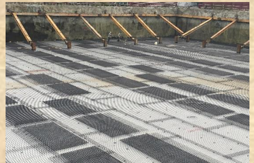
基礎上層鋼網寄料
