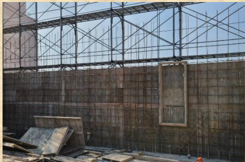
牆筋開口補強
