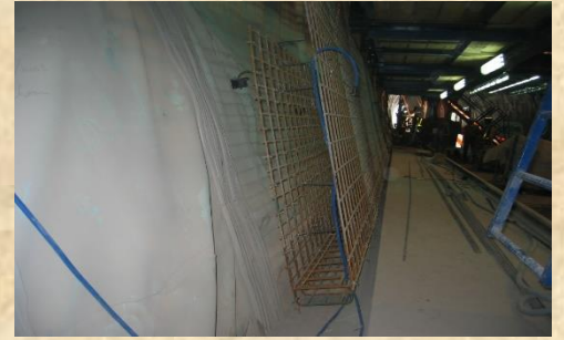
隧道二次襯砌
