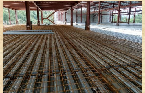
鋼網鋪設完成
